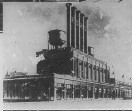
Vista exterior de la planta eléctrica de "Highland Park".
